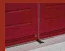
La dardenne sur appui de fenêtre permet le blocage des volets en position fermée.
